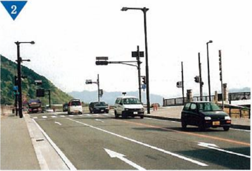
▲姫路上郡線祇園橋付近・祇園橋の整備（完了）
