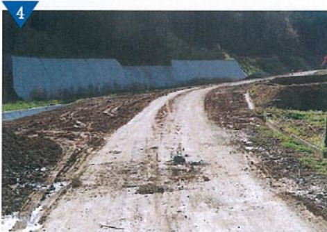
▲道路整備「町道大阪谷線」(進行中)
