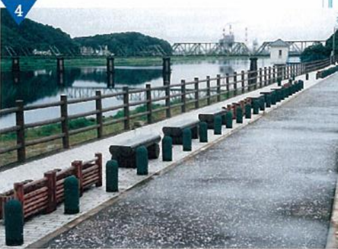
▲水辺を活かした散策道整備（進行中）
