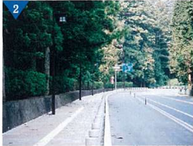
▲電線地下埋設（完了）
