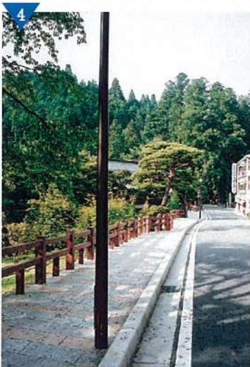
▲歩道整備（完了）
