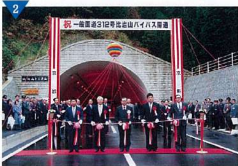
▲比治山トンネル整備（完了）
