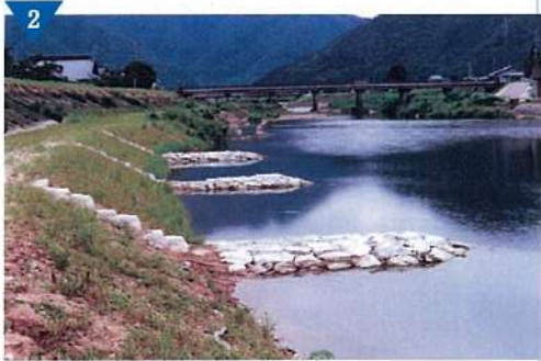
▲河川整備「出石川水辺の楽校プロジェクト」(完了)
