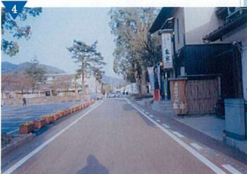
▲内町電線地中化、道路美装化整備「街並み環境整備」(完了)
