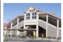
1 桜井駅南口 近鉄改札口をぬけて階段を上がりJR改札前を通る
