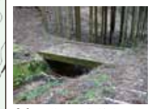
86 林道との交差点 砂防ダム工事により街道は失われている。現在は林道を左に少し上ってから谷治いの道を下る
