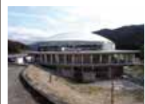
99 御杖小学校 ドームで覆われた円形校舎で中央のアリーナを囲むように教室が配置されている
