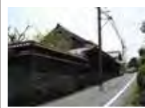
79 元本陣 道を挟んで庭園が残る
